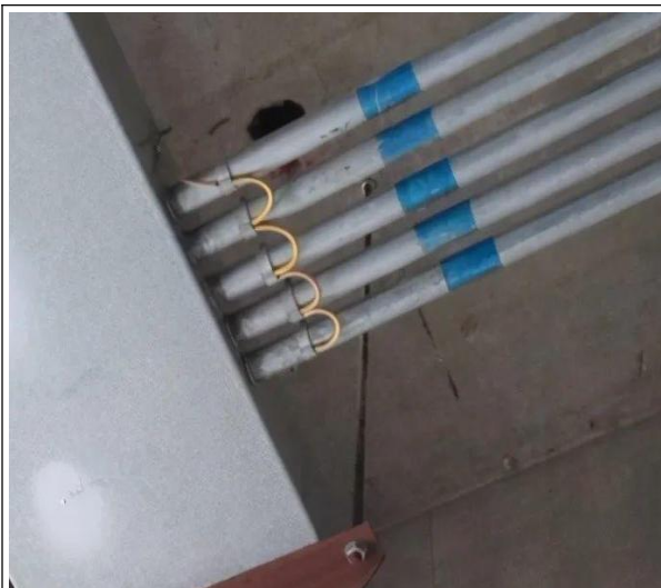
图 13-36 桥架引出金属管与桥架跨接
