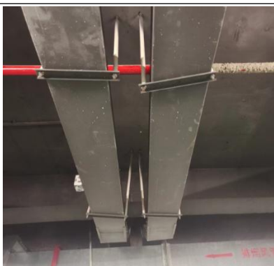
图 13-44 桥架横担未固定，丝杆外漏过长
