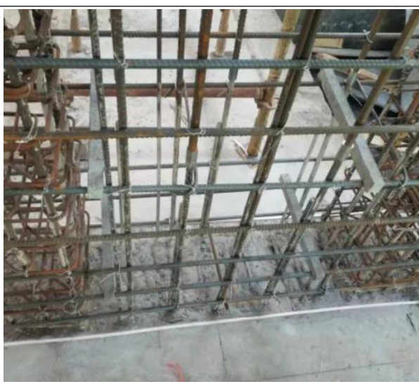
图 4-8 混凝土墙柱根部模板底面设置海绵条
