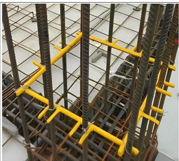
图 2-21 设置定位框
