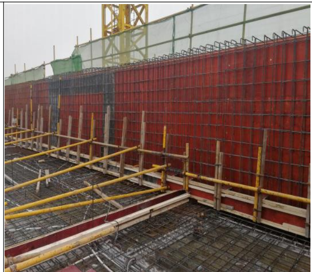
图 9-6 出屋面构造物泛水一次成型
