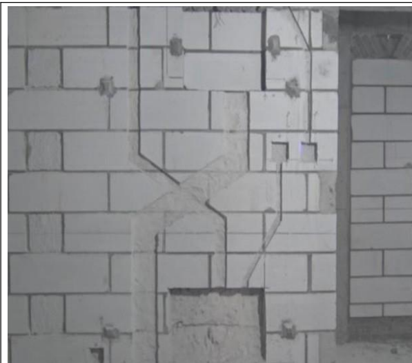
图 5-25 弹线切割，机械开槽
