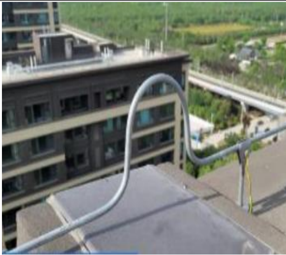
图 13-62 变形缝处Ω弯
