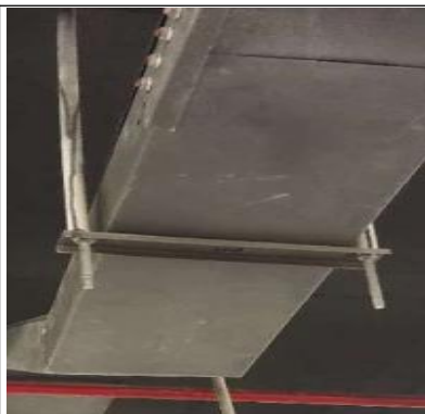
图 13-44 桥架横担未固定，丝杆外漏过长
