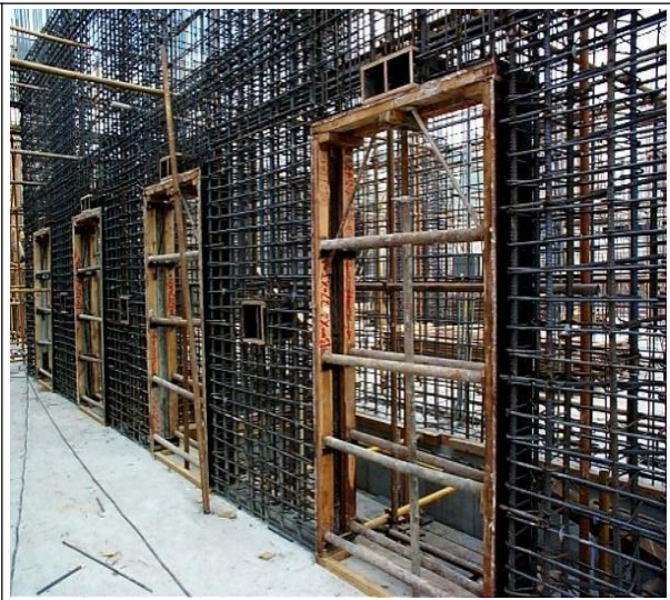
图 4-27 洞口模板内部加支撑固定
