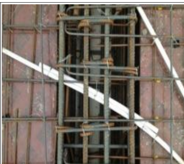
图 13-10 线管穿梁筋密集处加固措施
