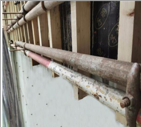
图 4-5 层间墙体混凝土模板下挂 100mm
