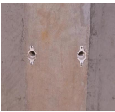
图 13-6 下翻线管成型效果
