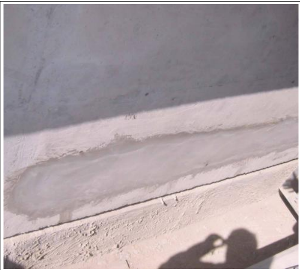
图 4-15 混凝土结构墙体蜂窝缺陷修复
