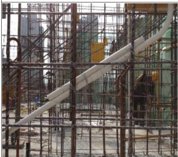
图 13-11 剪力墙线管接头处加固措施
