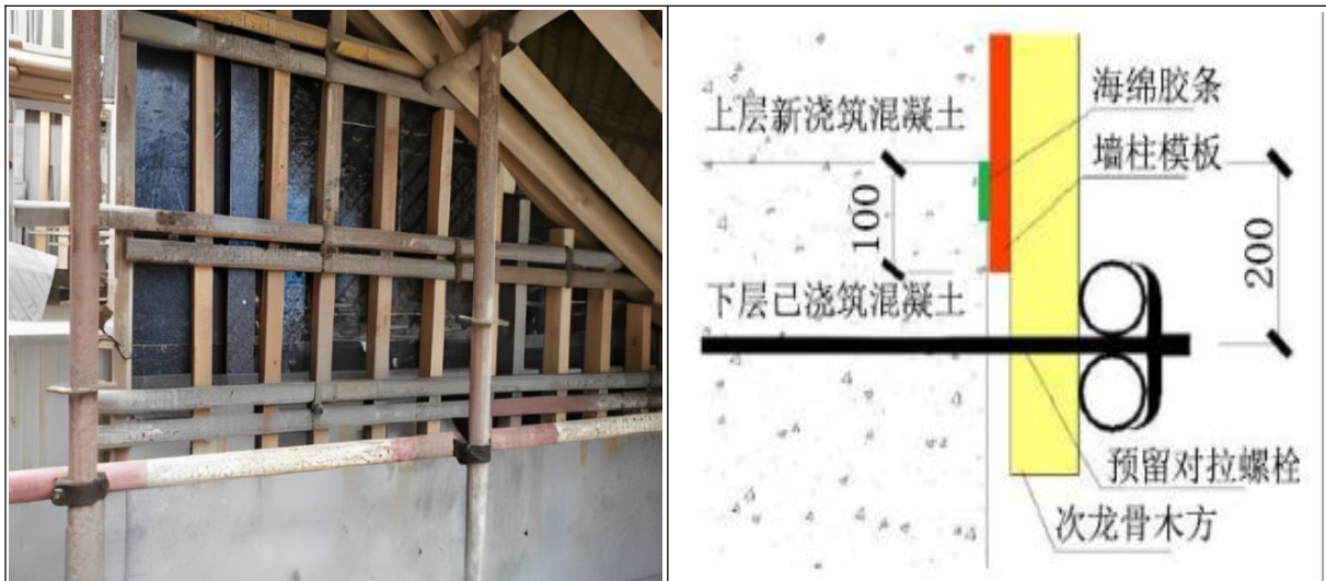
图 3-4 木模设置锁脚螺栓
