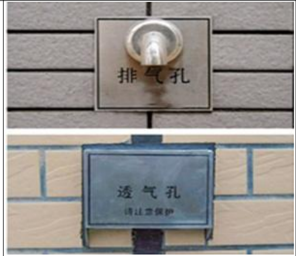
图 9-23 暗埋式排气管工艺
