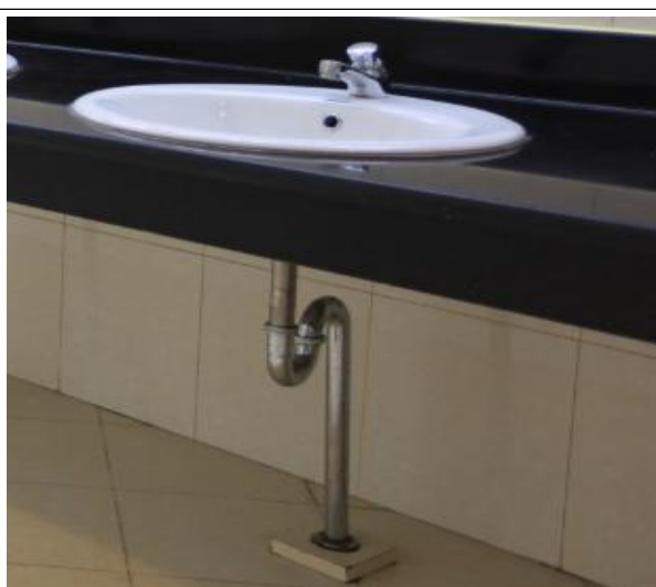
图 12-24 洗脸盆下水设置存水弯
