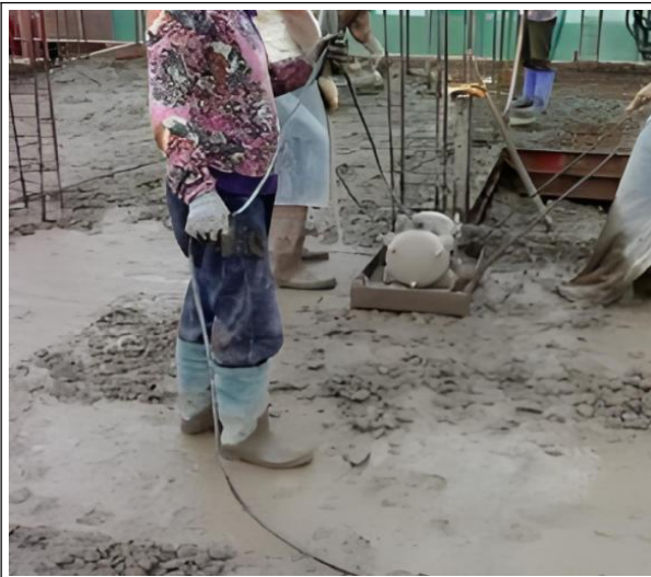
图 4-42 混凝土楼板采用机械振动
