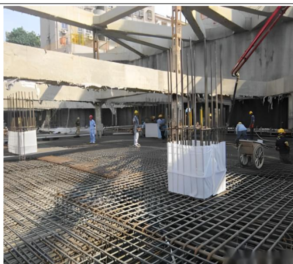
图 2-25 柱头钢筋用薄膜包裹
