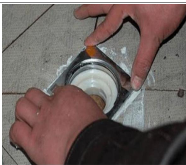
图 12-22 地漏打胶固定
