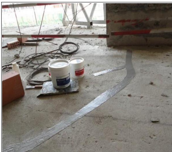
图 11-13 结构层裂缝处理
