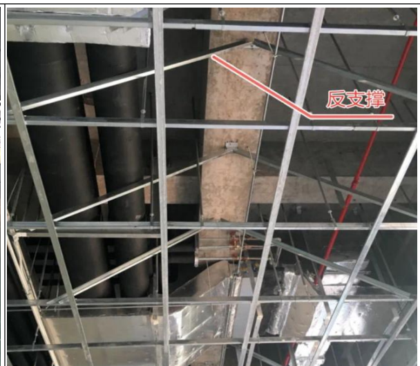
图 11-38 吊顶设置反支撑
