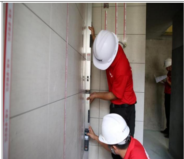
图 11-6 饰面砖平整度检查
