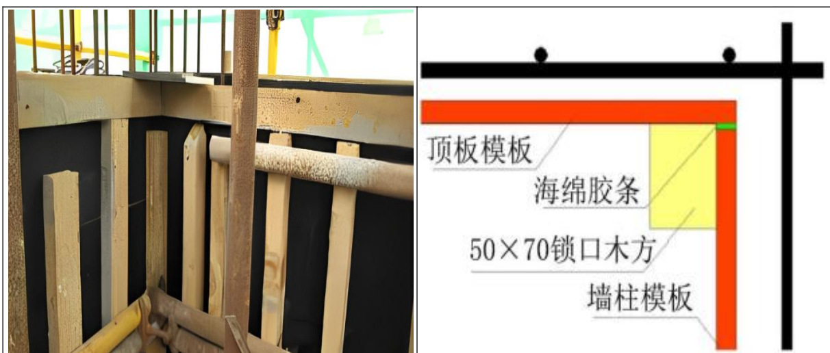
图 3-8 墙柱顶方木加固处理
