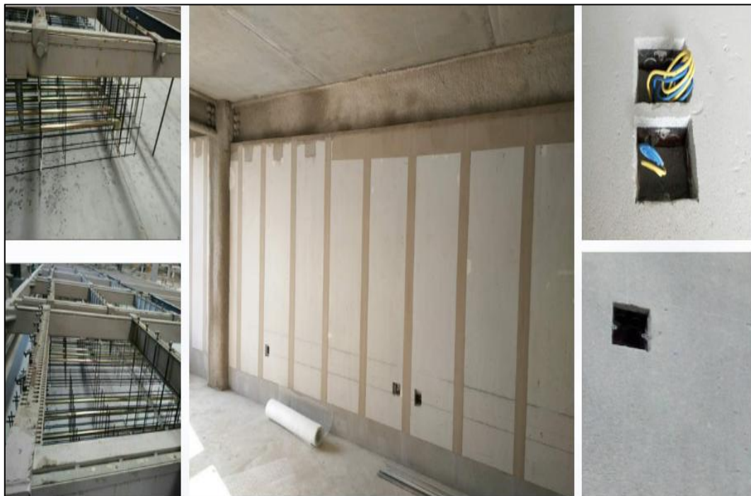
图 5-27 装配式 ALC 板，现场免开槽（管线一体板）
