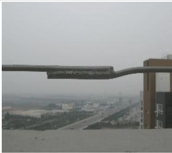
图 13-60 避雷带搭接做法（上平）
