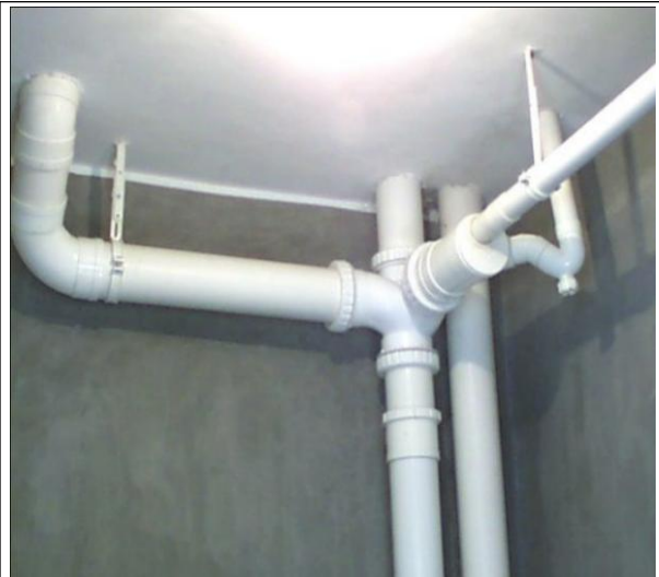
图 12-4 排水管道支吊架优秀做法
