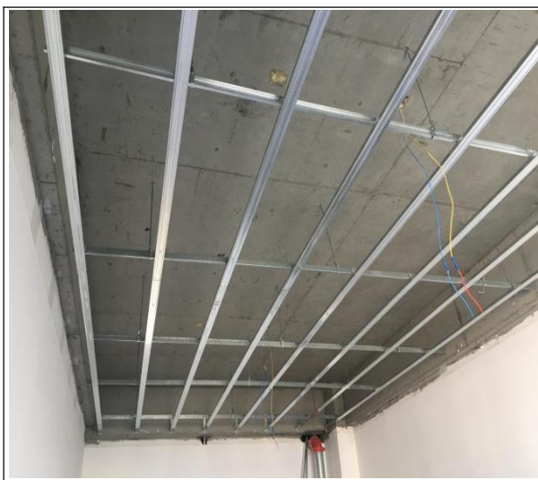
图 11-39 龙骨与结构连接牢固
