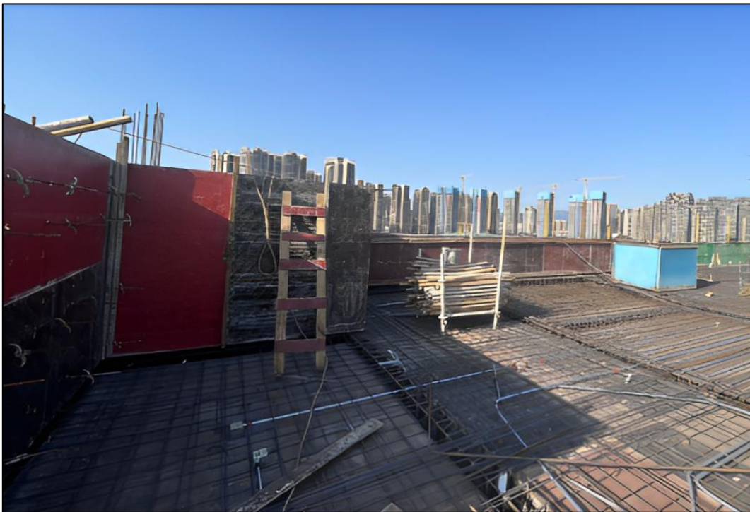
图 10-30 女儿墙混凝土结构一次上返
