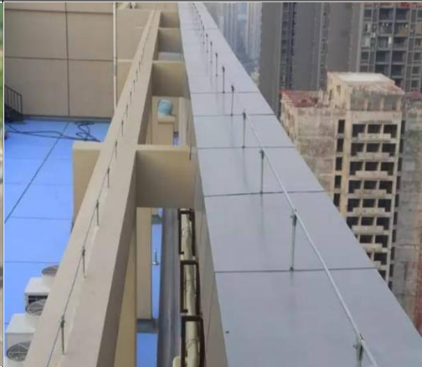
图 13-63 避雷带安装顺直、牢固
