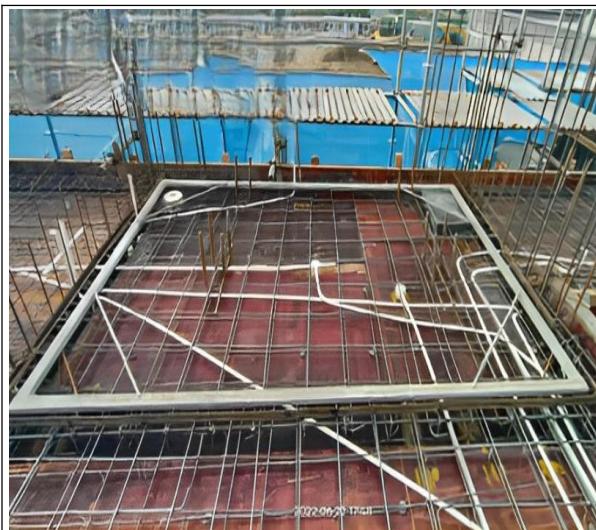
图 10-18 卫生间止水钢板
