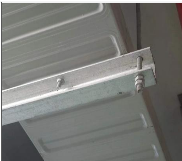
图 13-46 桥架横担固定措施
