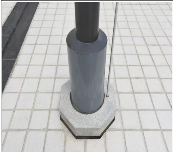
图 9-22 套管填充封堵密实
