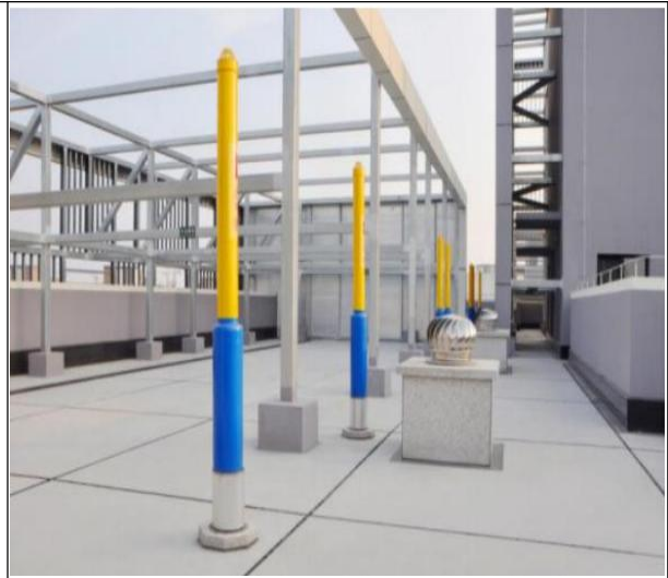
图 9-21 屋面通气管布置成型
