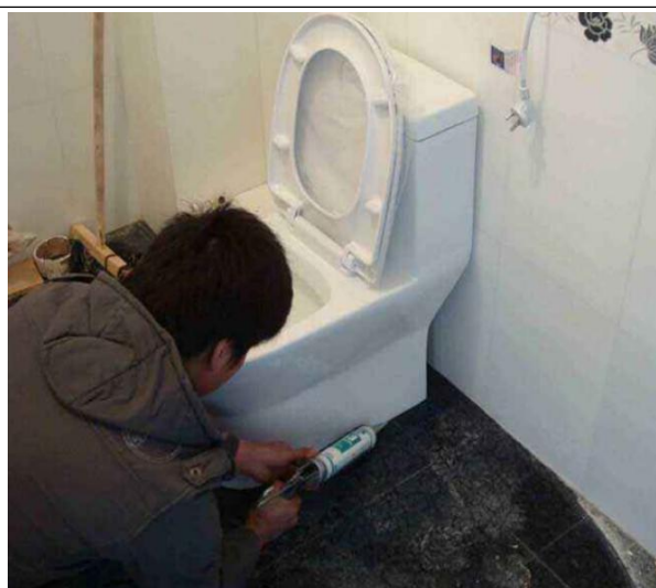
图 12-20 器具安装打胶固定
