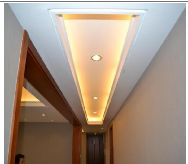
图 11-42 吊顶板面平整，无裂缝
