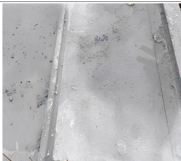
图 10-19 卫生间吊模及止水效果
