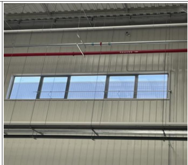
图 14-10 手动开启装置设置规范
