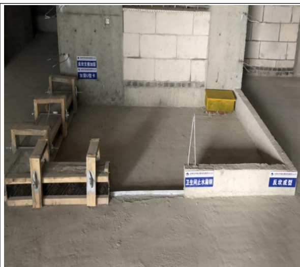
图 5-20 反坎成型效果
