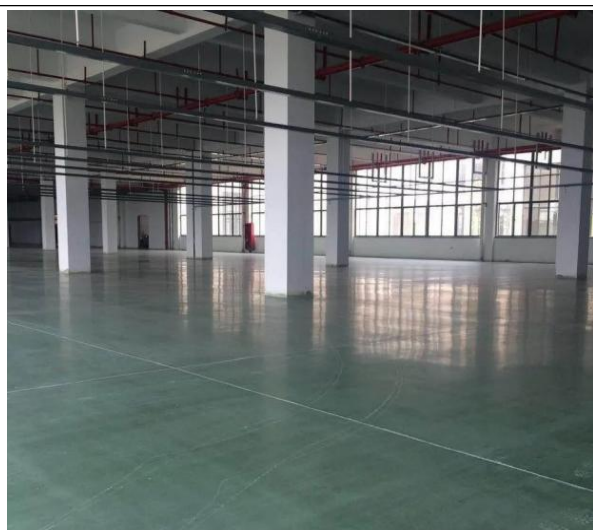
图 11-37 吊杆固定牢固
