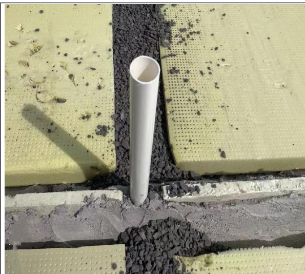
图 9-24 板缝嵌缝填充密实
