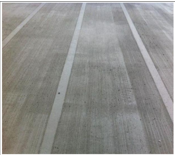
图 4-41 混凝土楼板面层拉毛
