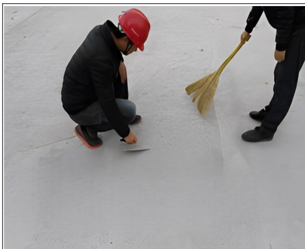
图 10-1 基底清理干净，无油污、未受潮、无积水剔除松散结构
