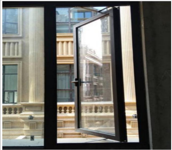
图 11-20 平开窗滑撑上下一条垂直线
