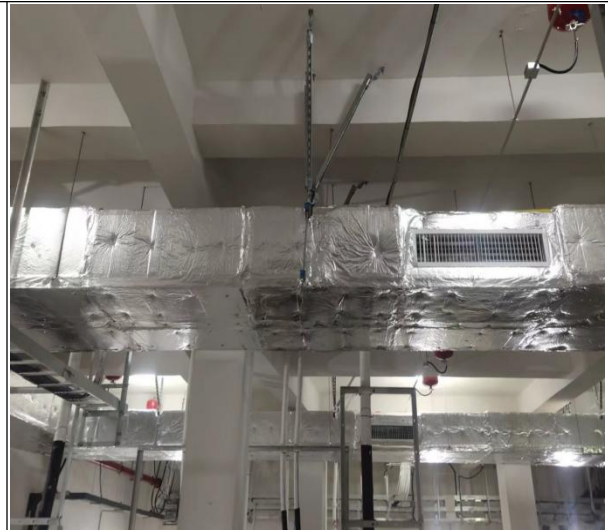
图 14-2 设置防火包裹，满足耐火极限要求
