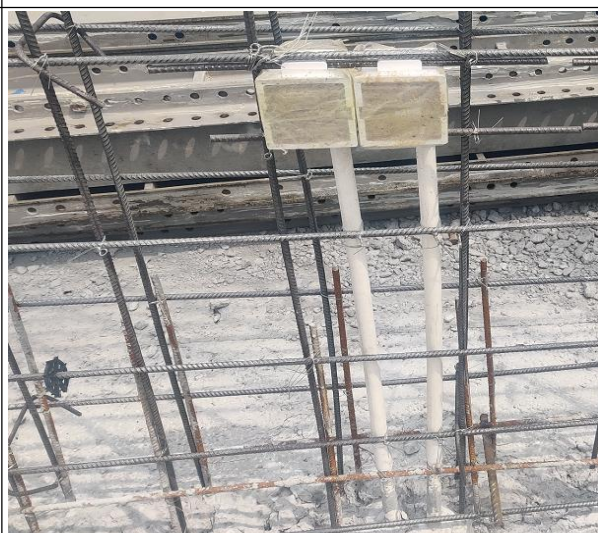
图 13-12 低位线盒上翻管一次到位
