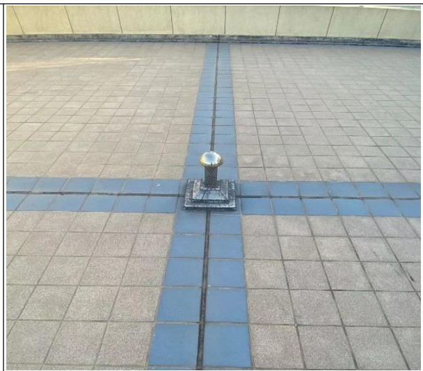
图 9-25 排气管设置
