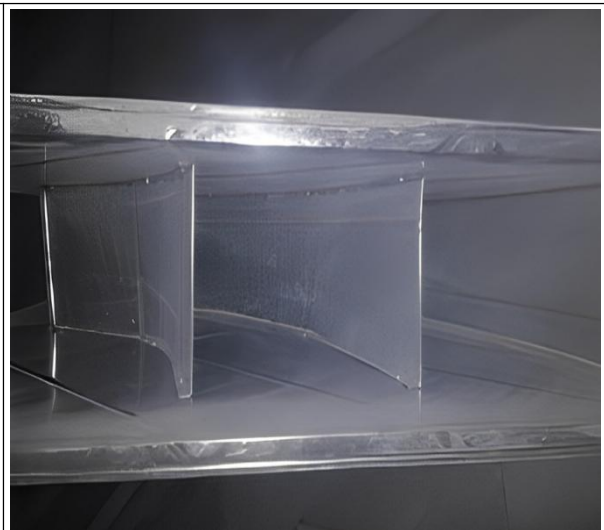
图 14-4 转弯处设置导流片
