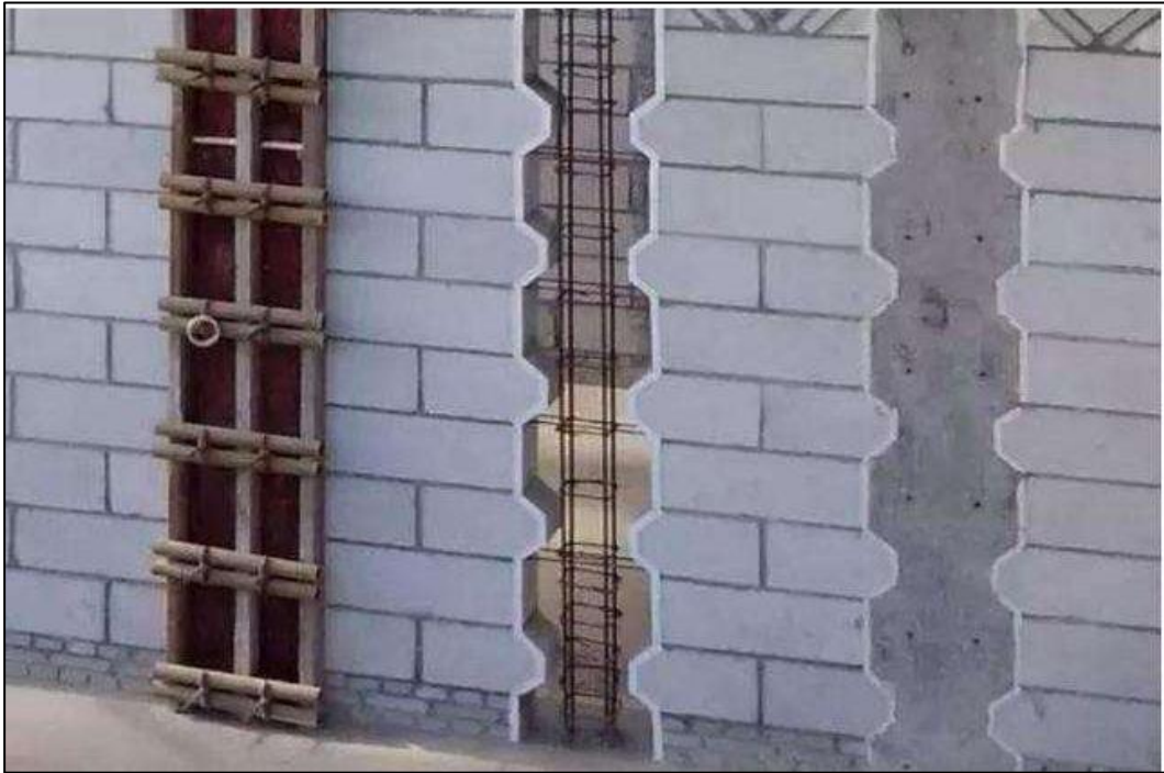
图 5-3 砖墙与构造柱连接实体样板
