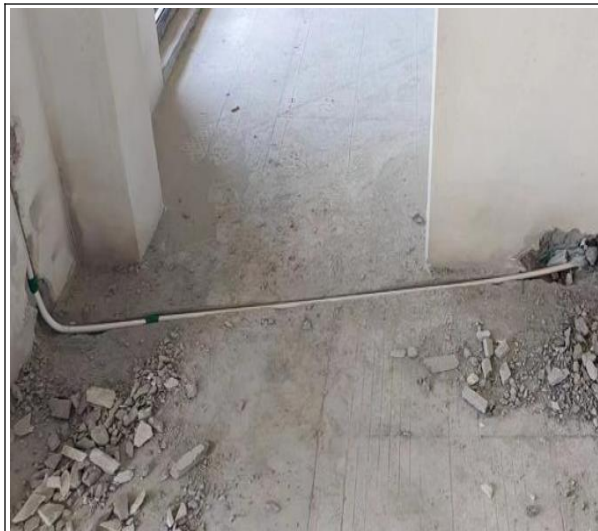
图 13-7 堵管后地面开槽
