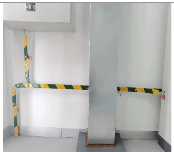
图 13-67 桥架、柜体接地示意
