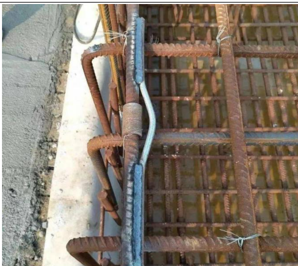
图 13-57 接地跨接线焊接
