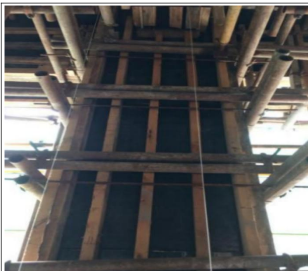
图 4-1 模板搭设时设置竖向垂直度控制线
