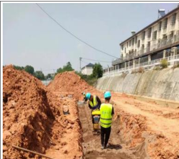
图 12-15 回填人工夯实
