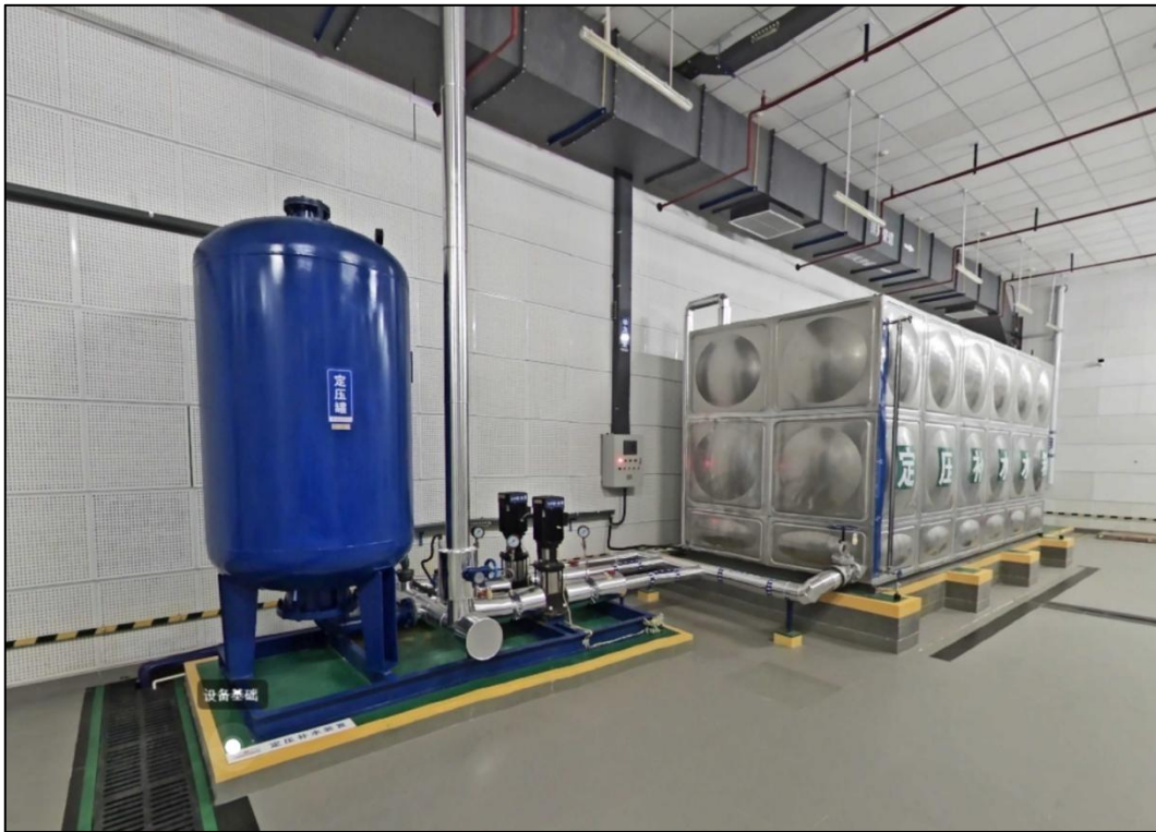
图 12-27 设备基础实例
