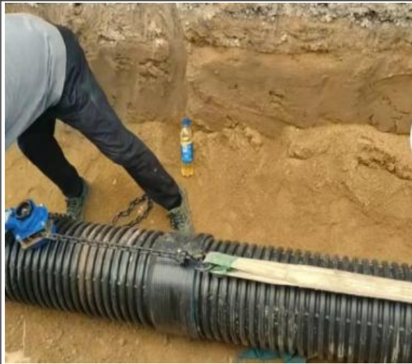
图 12-13 管道柔性连接
