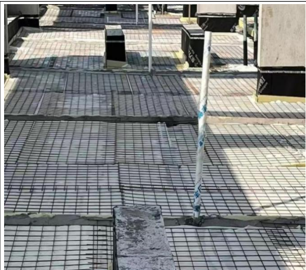
图 9-27 钢筋网片铺设
