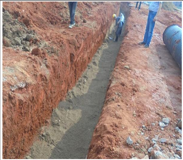
图 12-12 砂垫层铺设
