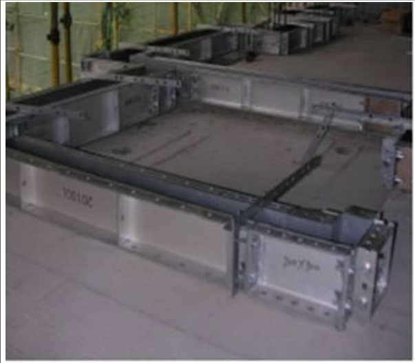
图 5-9 铝合金模板支设反坎
