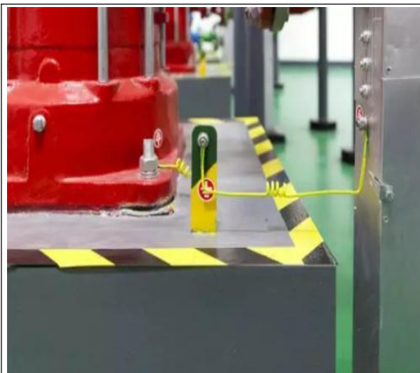
图 13-72 设备接地扁铁预留
