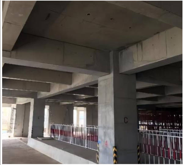
图 4-29 混凝土结构梁柱节点拦截成型效果
