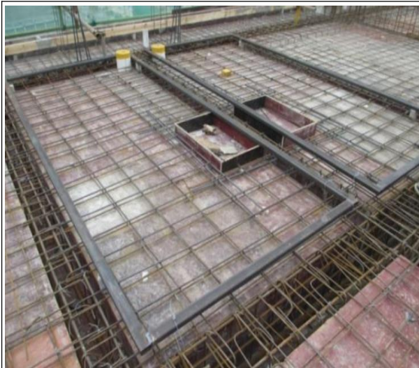
图 4-22 降板区域采用定型模板
