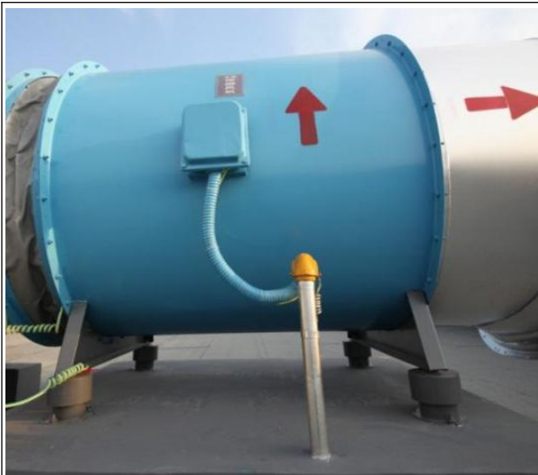
图 13-53 风机电源软管敷设
