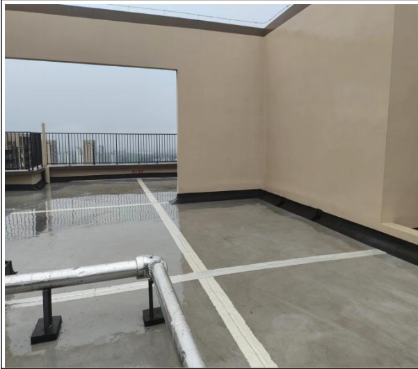
图 9-28 板缝嵌缝填充密实
