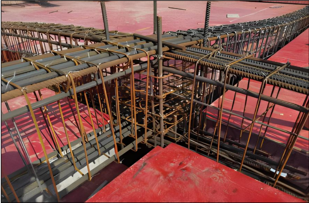
图 2-15 架立框架上安装梁筋
