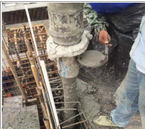
图 9-3 泵管出料口管卡
