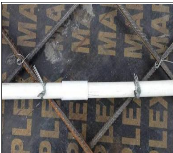
图 13-9 线管接头处加固措施
