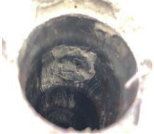
图 7-10 套筒堵塞
