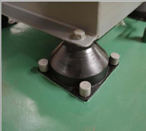
图 12-25 设备减振器
