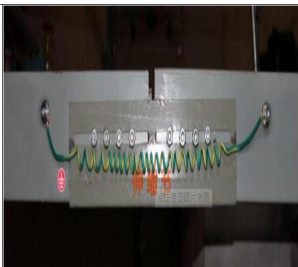
图 13-42 桥架伸缩节做法
