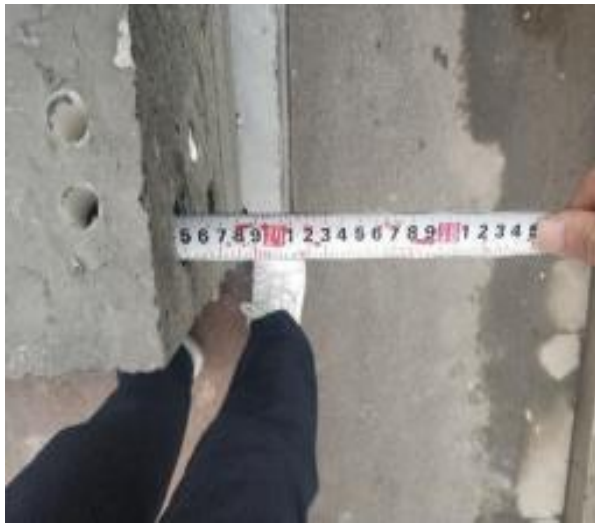
图 7-9 套筒内钢筋长度不合格
