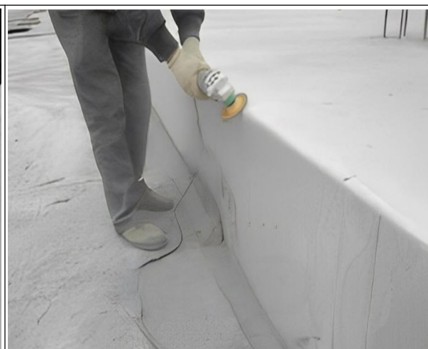
图 10-2 对阴阳角处进行打磨处理
