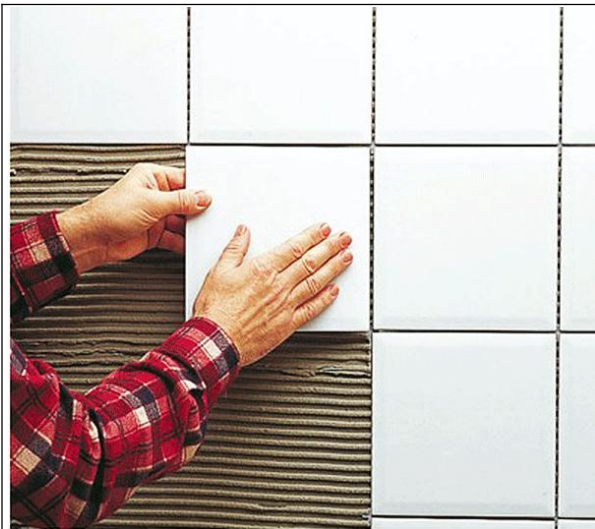
图 11-7 齿形抹刀处理粘结层
