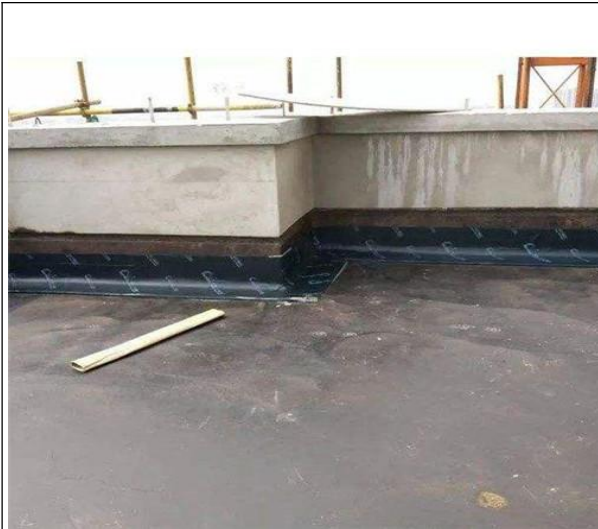
图 9-9 附加层施工高度
