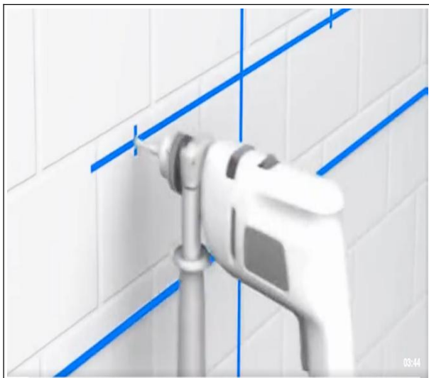
图 12-19 墙面画线定位钻孔
