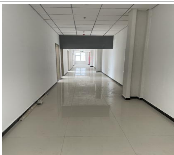
图 14-8 已设置挡烟垂壁
