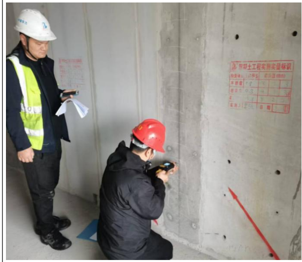
图 4-35 混凝土结构实体回弹
