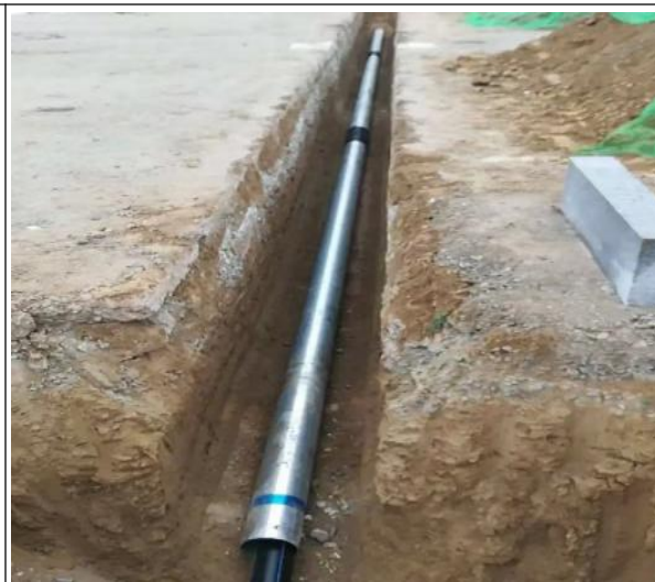
图 12-16 过路管设置套管保护
