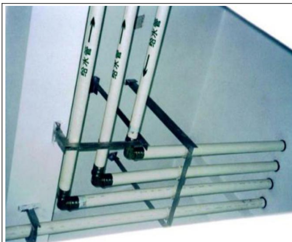
图 12-1 给水管道支吊架优秀做法
