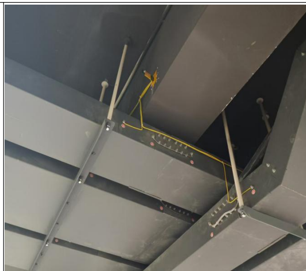
图 13-37 桥架与预留接地体连接
