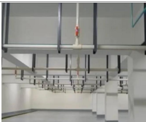
图 12-2 给水管道支吊架优秀做法
