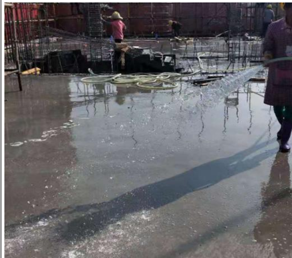
图 4-34 混凝土洒水养护
