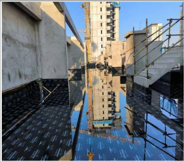
图 9-10 屋面防水层蓄水试验
