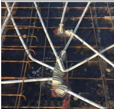
图 13-5 线管接驳器预埋效果
