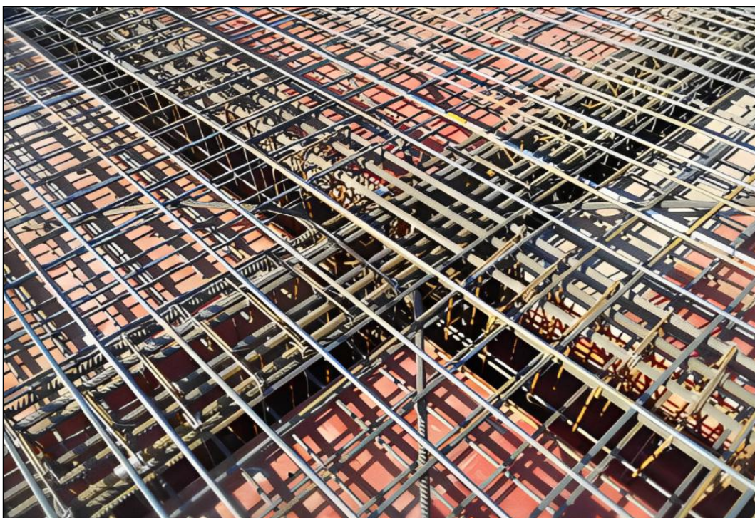
图 2-17 工序施工完成
