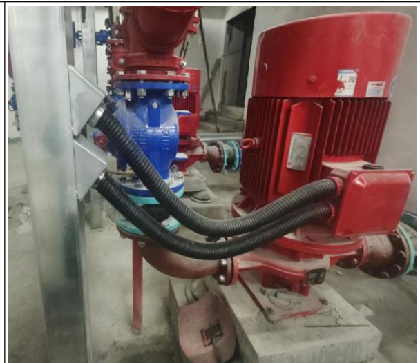
图 13-54 水泵电源软管敷设
