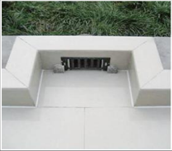
图 9-17 穿墙式水落口做法
