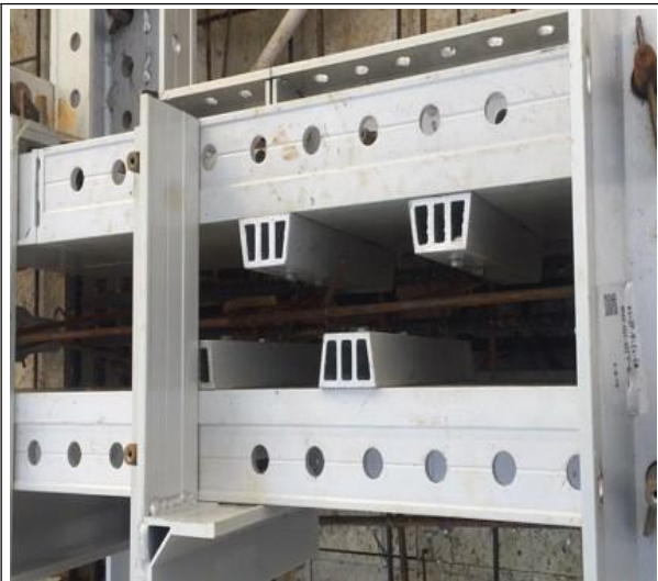
图 5-15 反坎预留压槽
