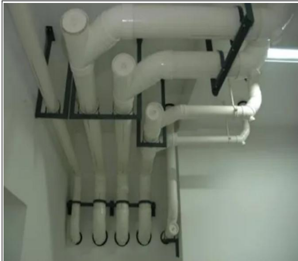
图 12-3 排水管道支吊架优秀做法
