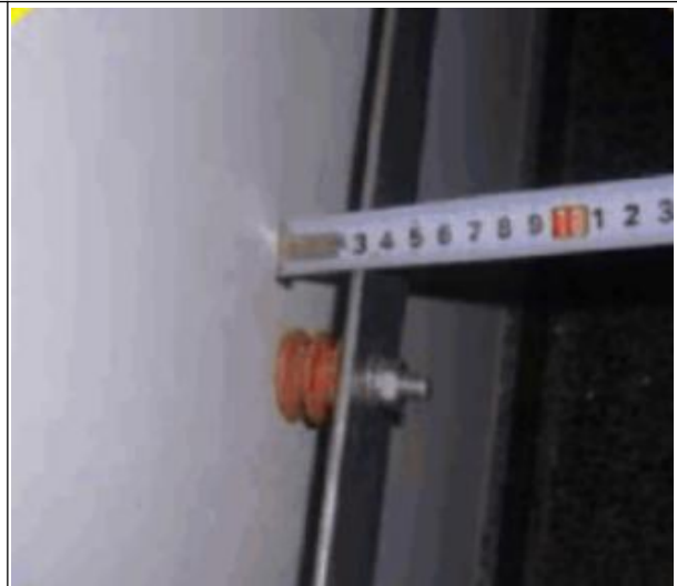
图 13-65 安装距墙面距离不符、无标识
