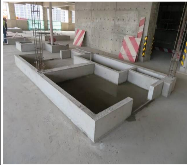
图 5-8 混凝土反坎成型质量
