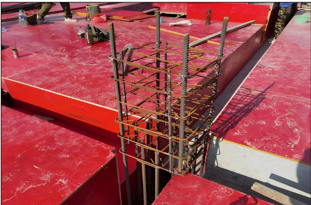
图 2-14 柱上架立安装辅助框架
