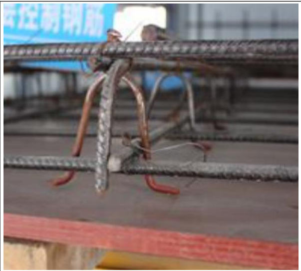
图 4-13 混凝土结构楼板设置马凳防露筋
