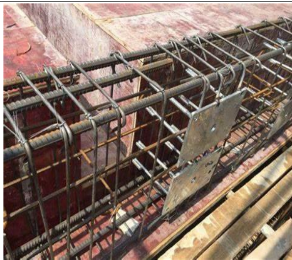
图 11-43 埋件与钢筋固定
