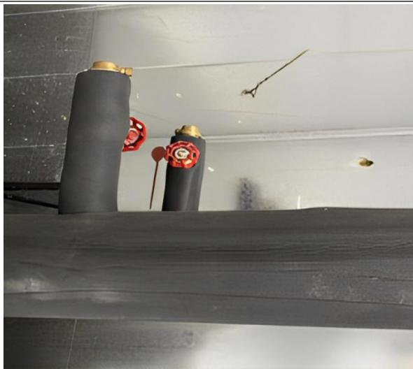
图 14-17 排气装置
