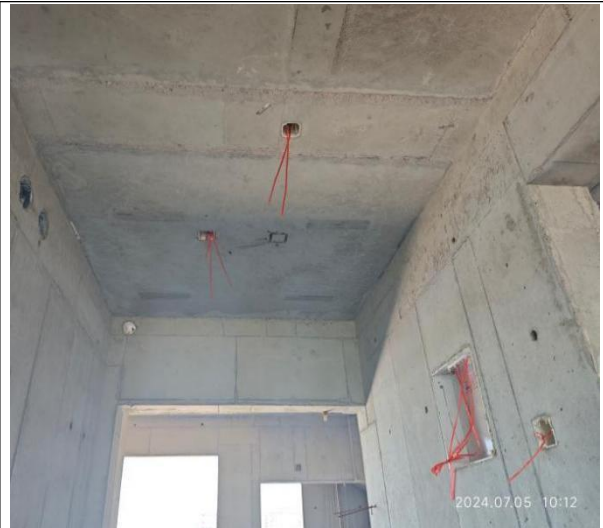
图 13-14 线管疏通穿引线
