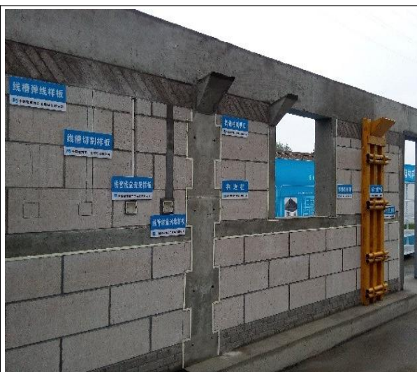
图 5-2 构造柱实体样板
