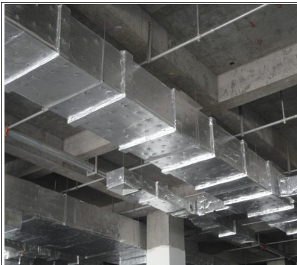
图 14-15 安装保温钉
