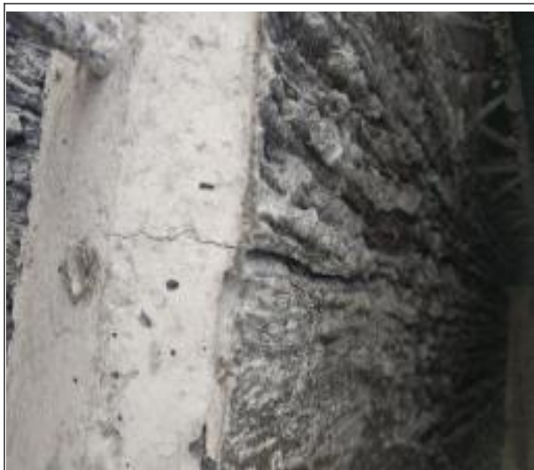
图 7-1 深层裂纹
