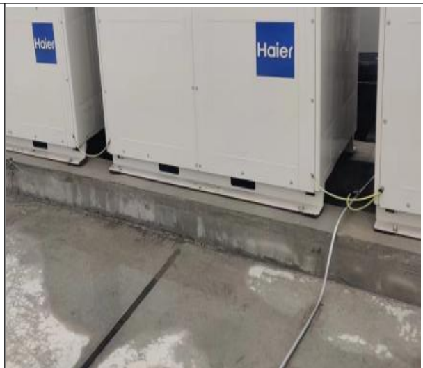
图 13-71 接地漏设、接地体后期地面明敷
