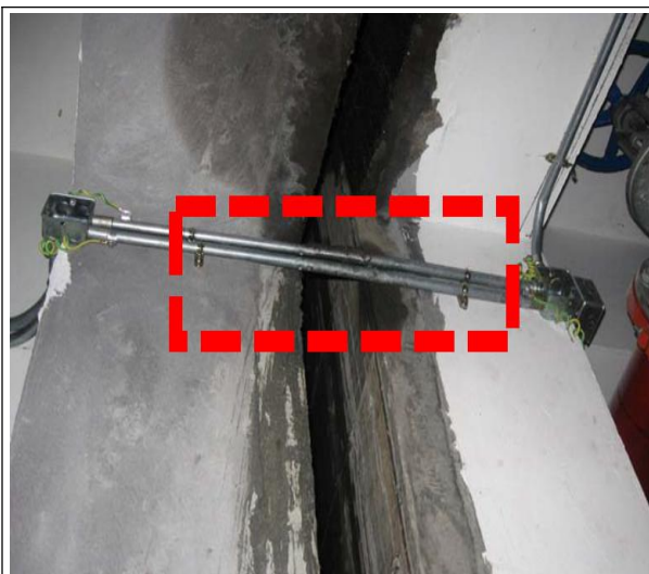
图 13-39 线管直接穿越变形缝
