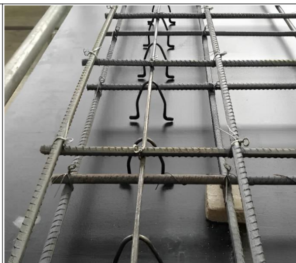
图 2-23 板面采用定型钢筋马凳
