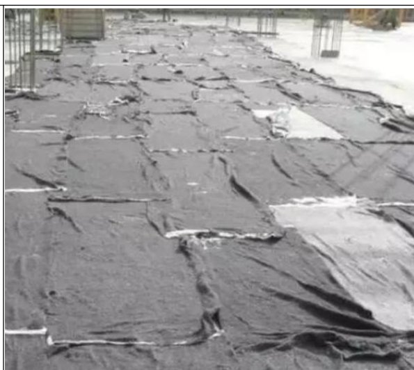
图 11-14 混凝土覆盖养护
