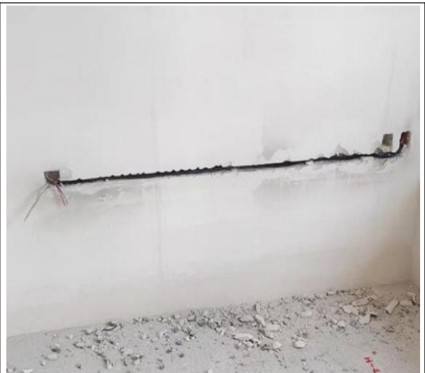
图 13-8 堵管后墙面横向开槽
