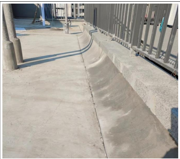
图 9-15 细石混凝土、水泥砂浆泛水施工应用
