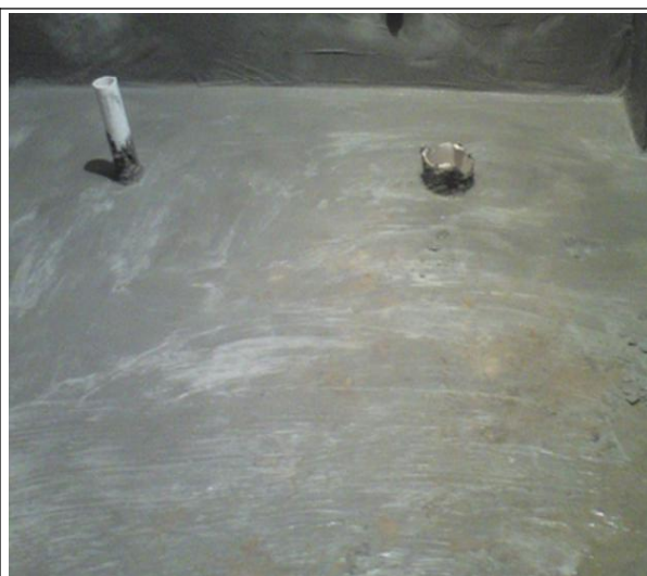
图 11-12 结合层施工（素水泥浆涂刷）
