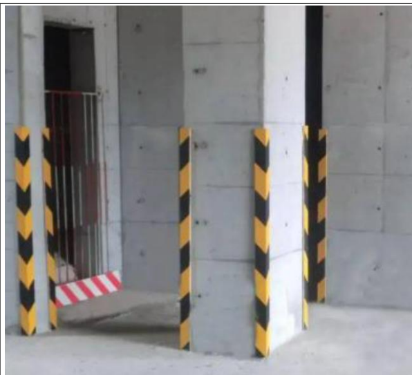
图 4-19 混凝土结构阳角防护
