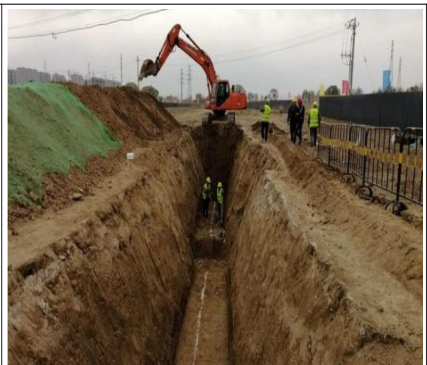
图 12-10 人工配合开挖
