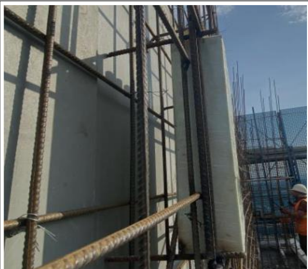
图 13-18 四角定位筋绑扎/点焊牢固
