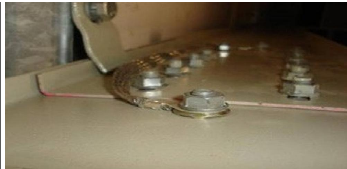
图 13-38 桥架跨接线压接顺序
