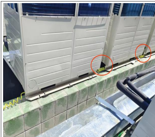
图 13-70 接地串联
