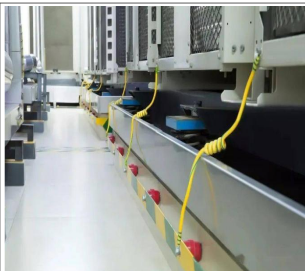
图 13-73 成排设备保护接地做法
