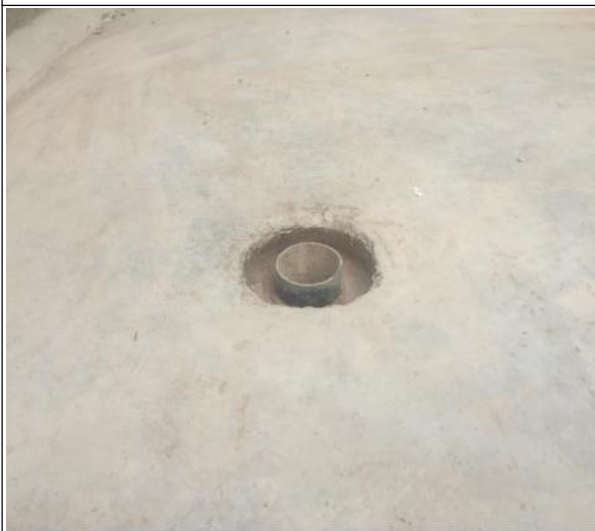
图 9-7 落水口结构预埋一次成活
