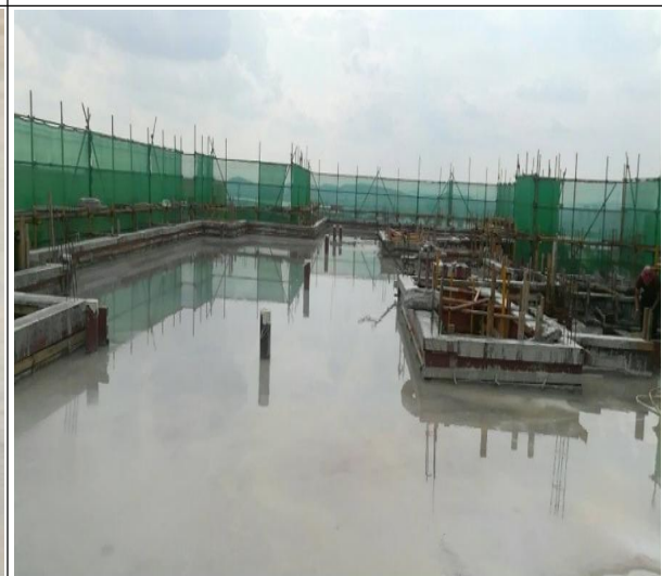
图 9-8 结构闭水试验
