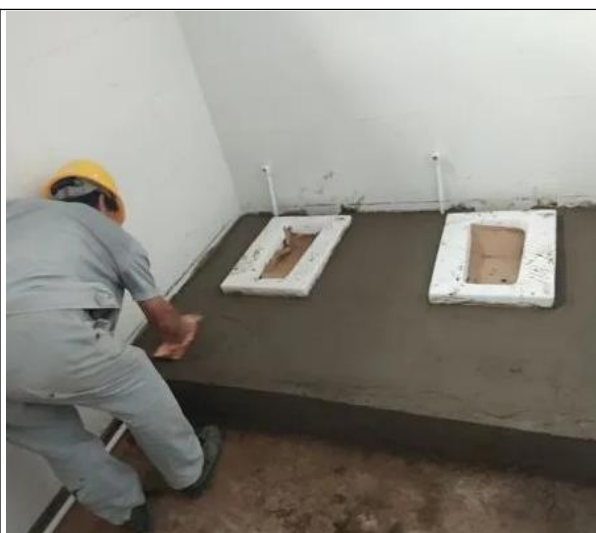
图 12-18 蹲便器施工过程中成品保护
