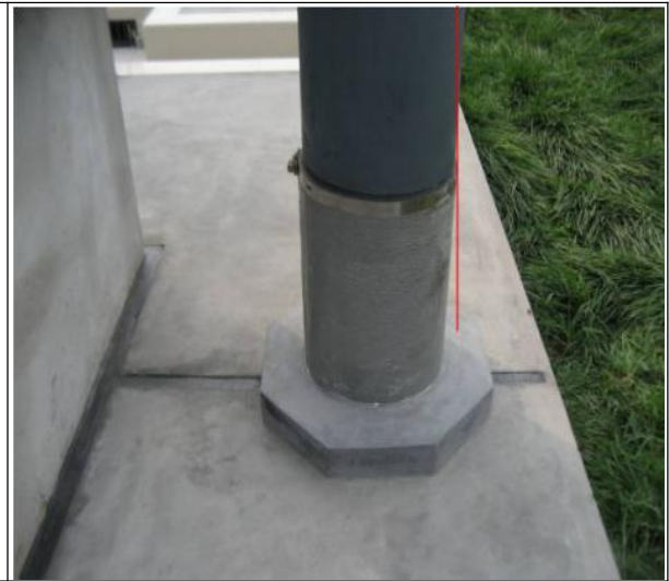
图 9-12 伸出屋面管道防水收口
