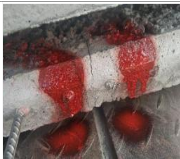
图 7-2 表面裂纹
