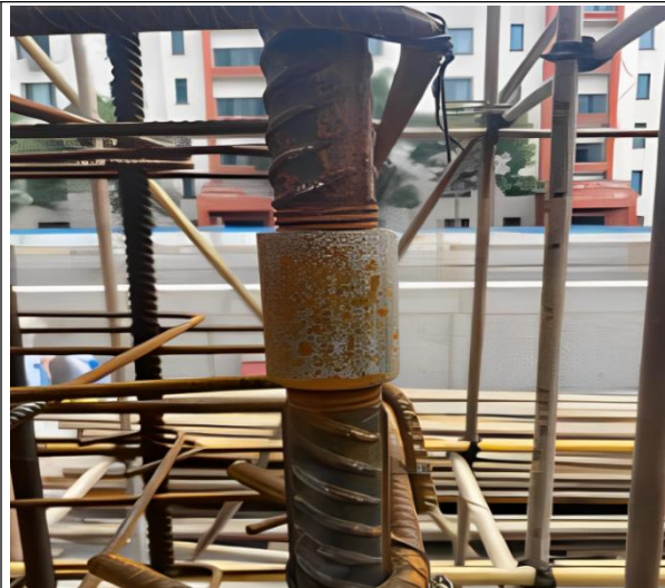
图 2-11 外露丝扣超过 2 个丝扣
