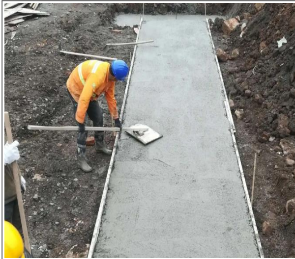
图 12-11 混凝土垫层收光处理
