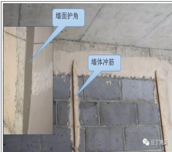
图 11-5 墙体抹灰处理
