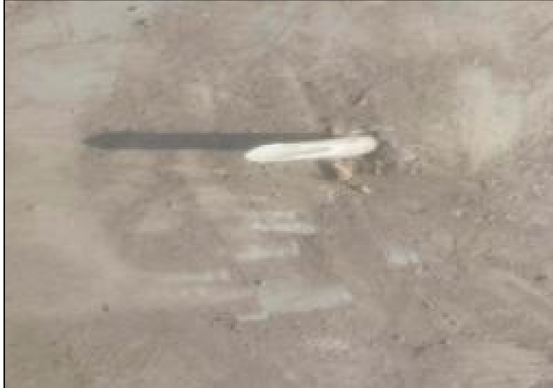
图 8-3 排气管损坏
