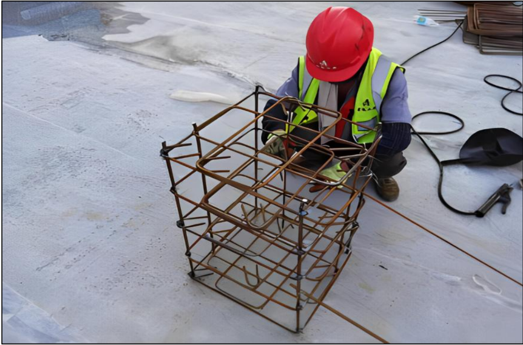
图 2-13 制作核心箍施工辅助框架
