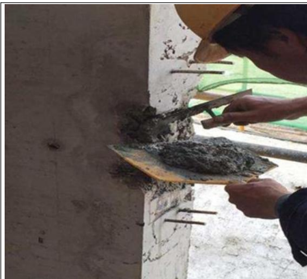
图 4-18 混凝土墙柱缺棱掉角缺陷修复
