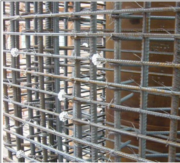
图 4-12 混凝土结构墙体设置支撑防露筋
